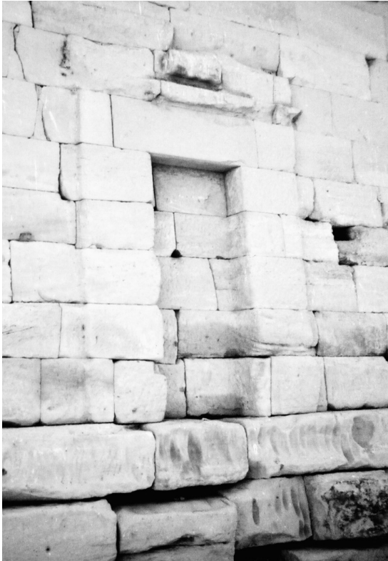
Abb. 13: Die türförmige Nische an der Rückwand des Tempels von Deir esch-Schelwit
