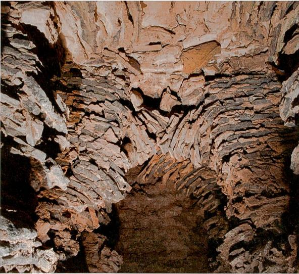
Abb. 15: Kaiseraugst AG, Liebrüti. Detailaufnahme der hitzgeschädigten Kragbögen 4 und 5 in der Heizkammer von Ofen ZK 50: Die Ziegel sind zusammengeschmolzen, verformt und paketweise abgesackt.
