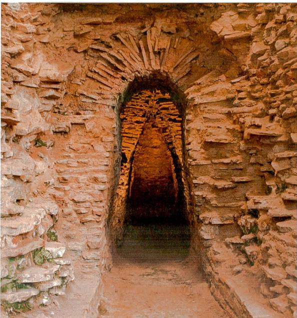
Abb. 12: Kaiseraugst AG, Liebrüti. Blick nach Norden durch den Schürkanal von Ofen ZK 50 in dessen Heizkammer. Während der Schürkanal mit einem Rundgewölbe überdeckt ist, sind dahinter in der Heizkammer Kragbogen zu erkennen.
