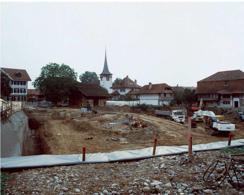
Abb. 4: Jegenstorf, Zuzwilstrasse/Iffwilstrasse. Situation der Baustelle. Blick nach Nordosten.
