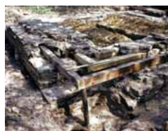
Mit modernen Karkhölzern rekonstruierter Ballustrast während der Grabung 1975. Der Einbau von Kant- und Rundhölzern diente dazu, den Turm während des Baus zu stabilisieren, was eine kürzere Bauzeit erlaubte.
