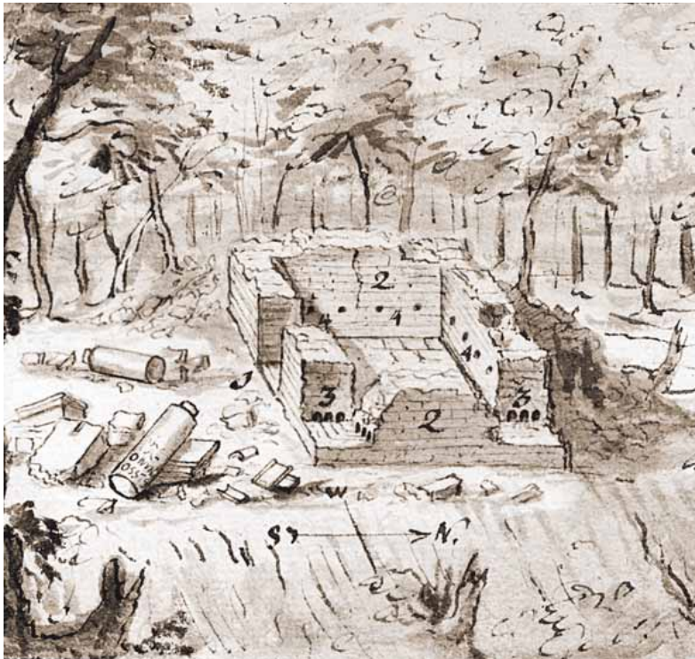
Zustand des Wachturms von Muttenz um 1750 (Ausschnitt aus einer Federzeichnung von Emanuel Büchel, Kupferstichkabinett Basel). Deutlich sind die Hohlräume zu erkennen, welche die eingemauerten und im Laufe der Zeit verfallenen Holzbalken hinterlassen haben.
