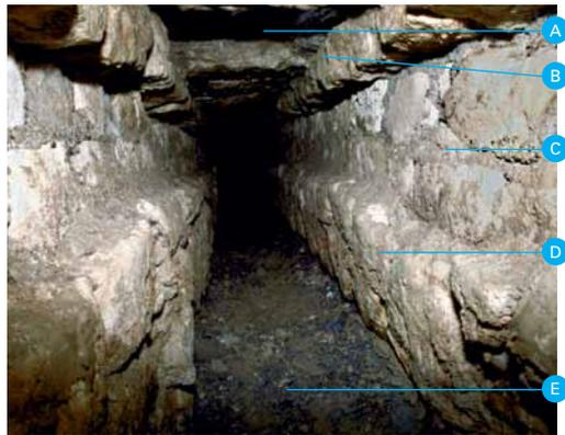
6 Oben: Querschnittszeichnung mit Darstellung des Aufbaus des Filter-Abschnitts der wasserführenden Leitung von Vindonissa. Das Wasser kann durch die seitlichen Trockensteinmauern in den Filterabschnitt einsickern. Unten: Blick in den Filterabschnitt im Gebiet der Gemeinde Hausen.
