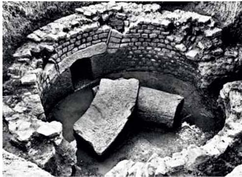
17 Im Sammelbecken von Eiserfey, D vereinigen sich die beiden aus Kallmuth (links) und Vollem (rechts) kommenden Freispiegel-Leitungen. Von dort floss das Wasser in einer grösseren Freispiegel-Leitung nach Köln.
