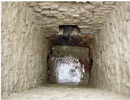
15 Blick in den Einstiegsschacht Nr. 8 der wasserführenden Leitung von Vindonissa. In der Bildmitte ist die kleine Zuleitung zu erkennen. In der Hauptleitung fließt das Wasser (unten) von rechts nach links.
