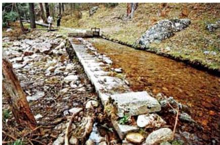
11 Das römische Stauwehr am Oberlauf des Rio de la Acebed. Es leitet Flusswasser in die rund 15 km lange Wasserleitung, die das antike Segovia (Spanien) mit Wasser versorgte.
