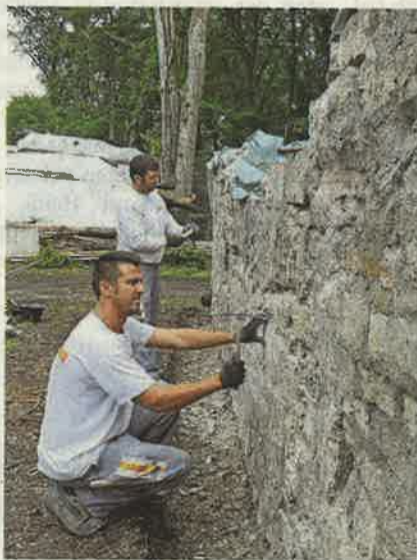
Facharbeiter sanieren die Mauer des Römerturms beim Koblenzer Laufen. ZA
