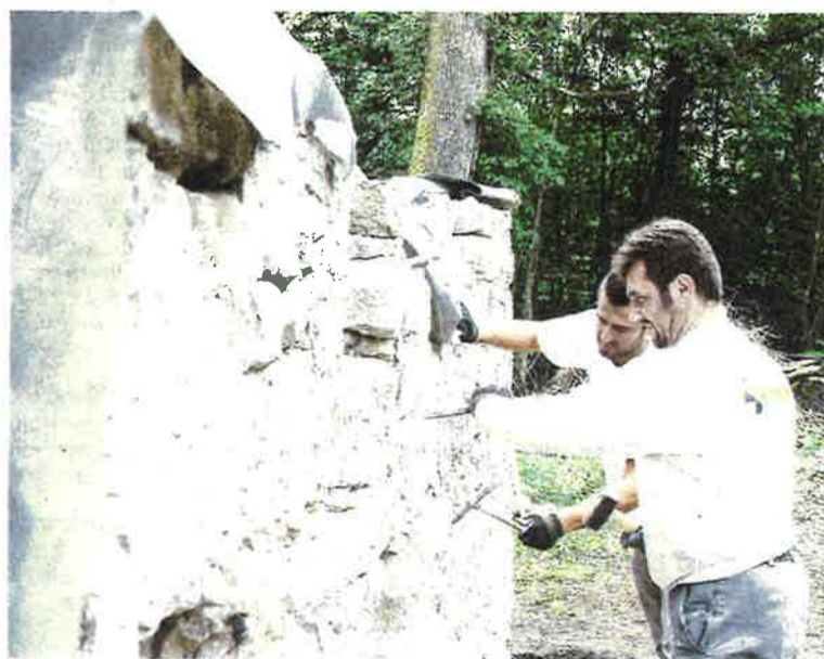
Die Arbeiter der spezialisierten Baufirma Gebrüder Sekinger AG müssen mit Finger- spitzengefühl vorgehen.
