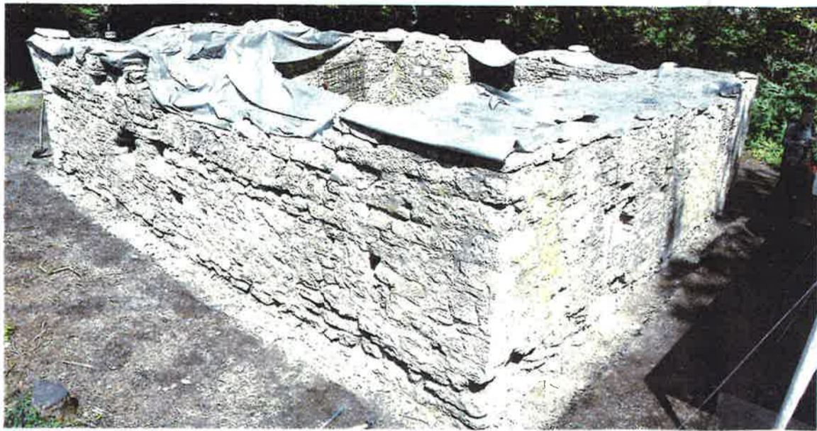
Der römische Wachturm von Koblenz, oberhalb des Kleinen Laufens, wird saniert und in Wert gesetzt.
