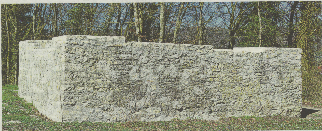
Der römische Wachturm präsentiert sich nach der Sanierung in neuer Frische.
