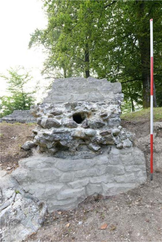
Abb. 7: Möhlin-Fahrgraben (AG). Im antiken *opus caementitium* sind die Negative der mittleren und obersten Lage der Holzarmierung zu erkennen, darunter die im Text erwähnte Baufuge. Die grau eingefärbten Mauerpartien kennzeichnen die moderne Unterfangsmauer (unten) bzw. moderne Ergänzungen (oben).
