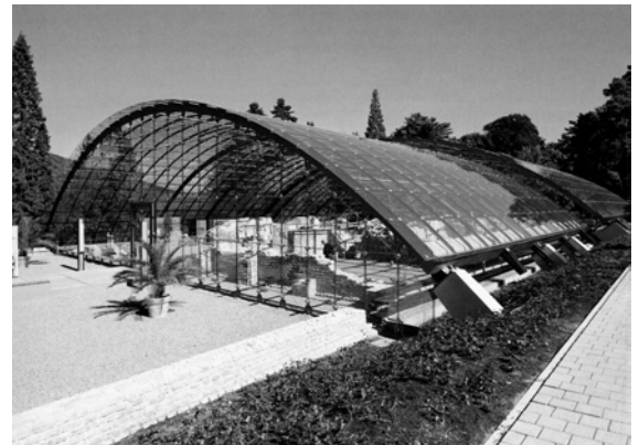
Ansicht des Schutzbaus über der Badenweiler Badruine (Prov.-Röm. Arch., Universität Freiburg i. Br.).
