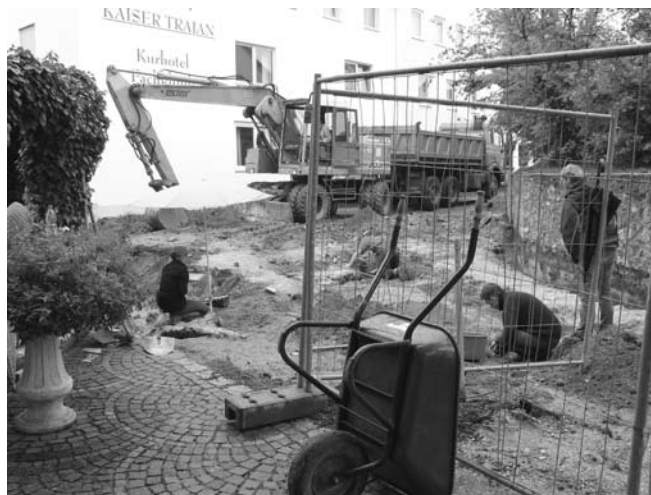
Abb. 1 Bad Gögging 2006. Nach Entfernen der Straßendecke setzt sogleich die archäologische Spurensicherung ein: gezieltes Freilegen und maßstabgetreue Dokumentation. Im Vordergrund Südmauer eines mit Fußbodenheizung versehenen Badesaals. Foto Gabriele Seitz
