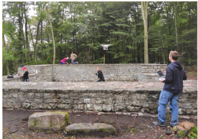
Abb. 6: Bei der Bauuntersuchung des spätantiken Wachturms Rheinfelden-Pferrichgraben kam u. a. auch ein Quadrocopter zum Einsatz.
