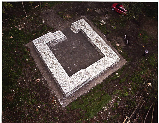
Abb. 6: Blick auf den spätantiken Wachturm Rheinfelden-Pferrichgraben (Rhe.016.01) nach Abschluss der Sanierung im September 2017.
