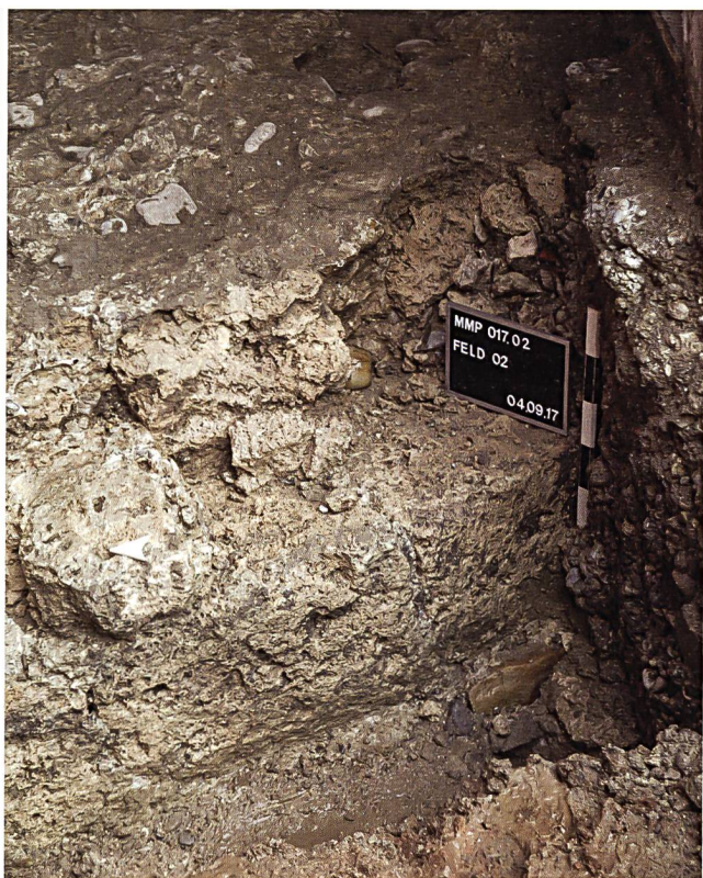
Abb. 7: Blick an die aus grossen Tuffsteinquadern bestehende, halbrunde Mauerschale des östlichen «Treppenturms» des spätantiken Magazinbaus Mumpf-Burg (Mmp.017.02).
